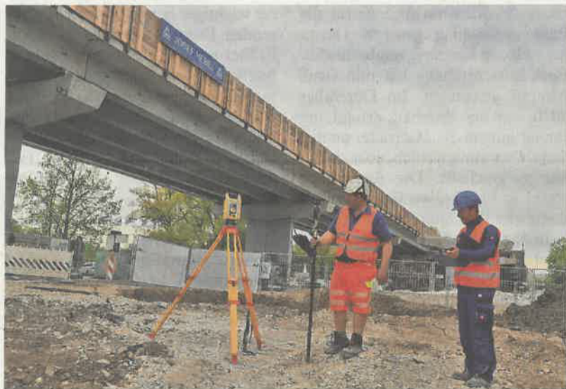
Größter Auftrag ist aktuell die A96-Brücke über den Stadtpark „Neue Welt“ in Memmingen. Bis 2024 wird dort gebaut. Fotos: Uwe Hirt (2)
