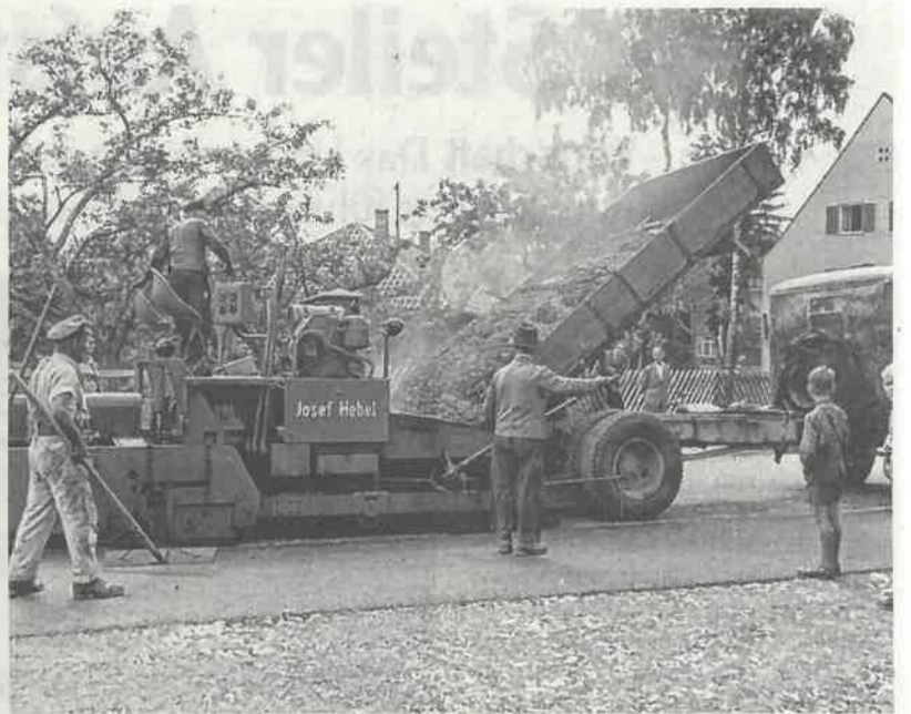
In den 1950er Jahren entstand dieses Bild von einer Straßenbaustelle. Dabei spielte auch die Mischanlage in Benningen eine wichtige Rolle. Fotos: Firma Hebel (3)
