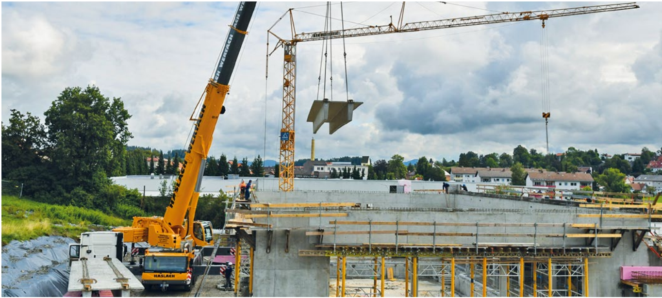
Die Fotos auf dieser Seite zeigen die Montage der Betonfertigteile.
